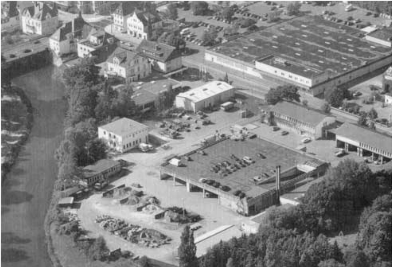
Die SWK wächst: Bis zur Aa erstreckt sich das Gelände der SWK, der Gesellschaft für Abfallentsorgung, Grünflächen und Straßenunterhaltung. Jetzt wurde das neue Sozialgebäude (das weiße schlichte Haus in der linken Mitte des Fotos) eingeweiht. FOTO:KIEL-STEINKAMP
