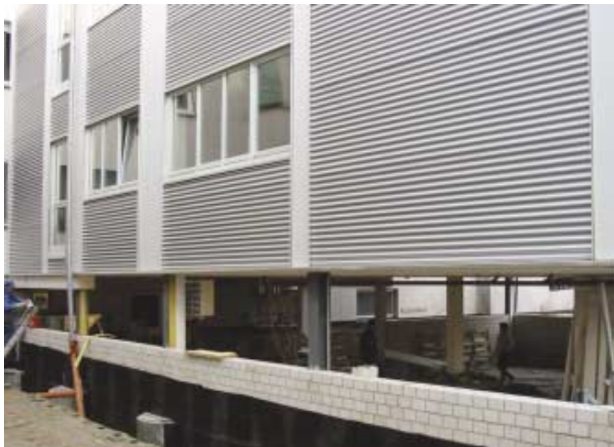
Der Klinik-Neubau in Stadtlohn wurde von OFRA freistehend errichtet. Dafür wurden 280 mm-Doppel-T-Stützen auf sechs Meter tief eingelassen. Fotos: Ofra
