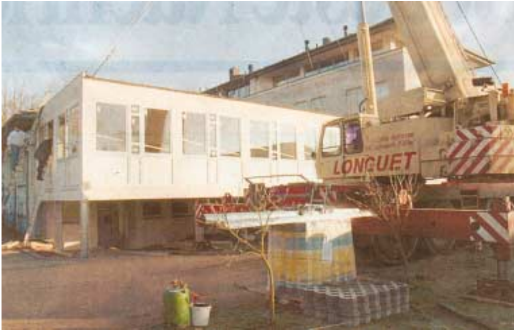
Gestern Morgen begann die Montage des neuen Wintergartens für das Hotel Godewind, in zwei Wochen ist alles komplett fertig. Fotos: Peter Günther (2)
