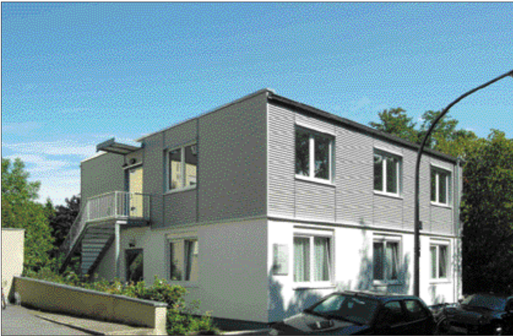
Aufstocken nach Bedarf – wie hier bei einem Gebäude der Universität zu Köln – ist durch Systembauweise problemlos möglich.
