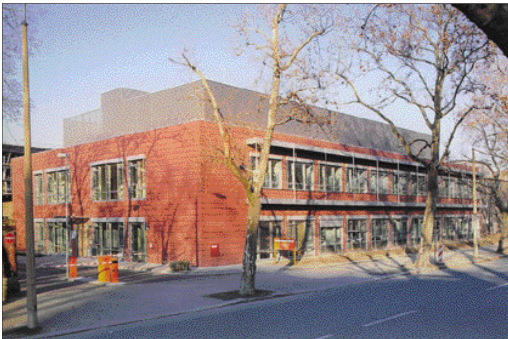
Vor allem enorm verbesserte Hygienemöglichkeiten und kurze Bauzeiten sprachen für Systembauweise bei der Erweiterung des Universitätsklinikums Leipzig. Bilder: OFRA
