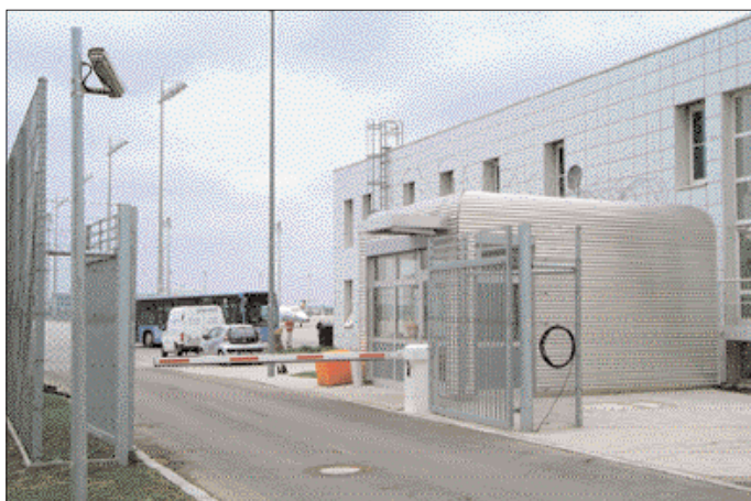
Die Kontrollstellen für Airport-Beschäftigte wurden Zeit sparend in Modulbauweise errichtet. Bilder:OFRA
