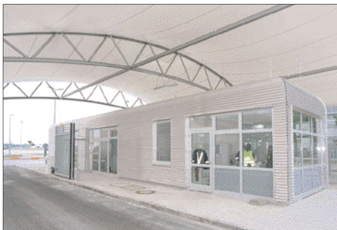
Die Kontrollstellen für Airport-Beschäftigte wurden Zeit sparend in Modulbauweise errichtet. Bilder:OFRA
