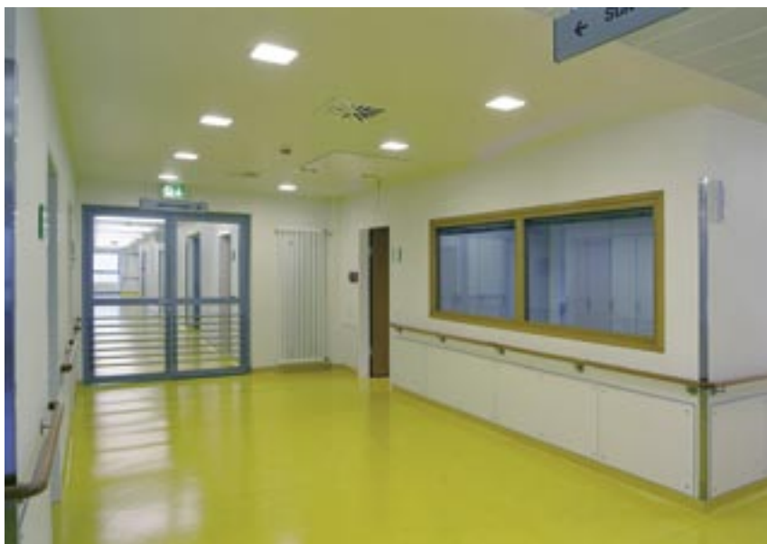
Feststellbare großformatige Flurtüren garantieren eine leichte Passage beim Bettentransport wie auch für Behinderte oder geschwächte Personen, die an durchlaufenden Handläufen halt finden.
