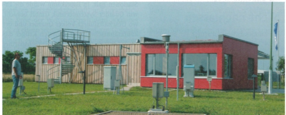
Besonderer OFRA-Bau für den Deutschen Wetterdienst in Rheinstetten: Die Fassadenkombination aus sibirischem Lärchenholz und rotem Trespa setzt Akzente.
