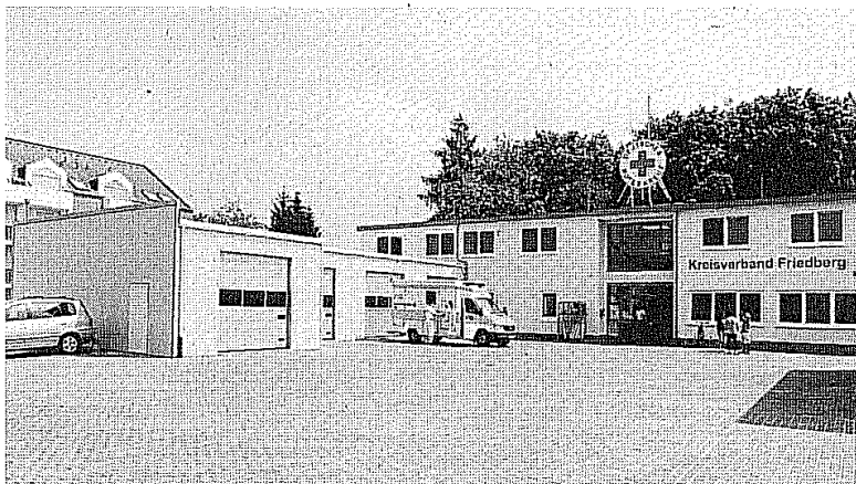
Gesamtansicht der im vergangenen Jahr in Betrieb genommenen Kreisgeschäftsstelle des DRK-Kreisverbands Friedberg. Foto: Ofra
