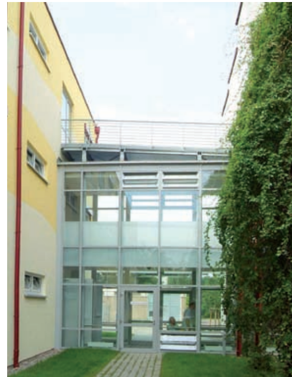
Der verglaste Durchgang stellt die Anbindung an die Infrastruktur des Haupthauses sicher
